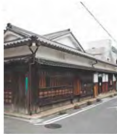
上／土間に梁と束(つか)、貫(ぬぎ)で構成する壮大な小屋組を持つ山口家住宅の外観。右ベージュ／土間に面した中の中。江戸時代を通じて増築が加えられたため、部屋によって微妙に異なる素材や工法が見られる。
